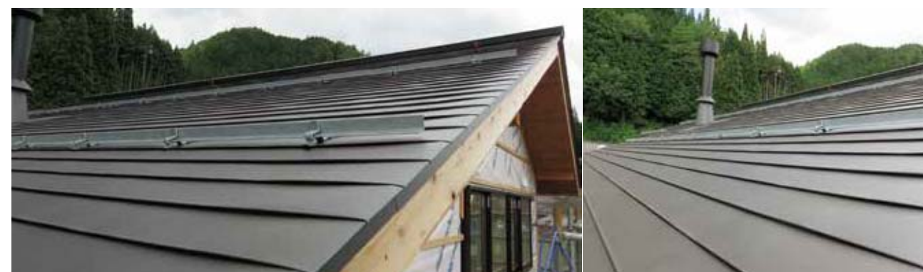
耐摩カラーを使用した屋根の施工中のようす
