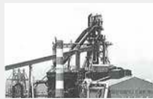
新日本製鐵株式会社 大分製鐵所(当時) 高炉の屋根材として「強化カラー鋼板」が採用。のちの追跡調査により、製鐵所の極めて高い腐食環境下において、卓越した耐久性が確認された。
