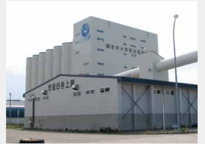
網走港 集出荷施設 / 北海道
