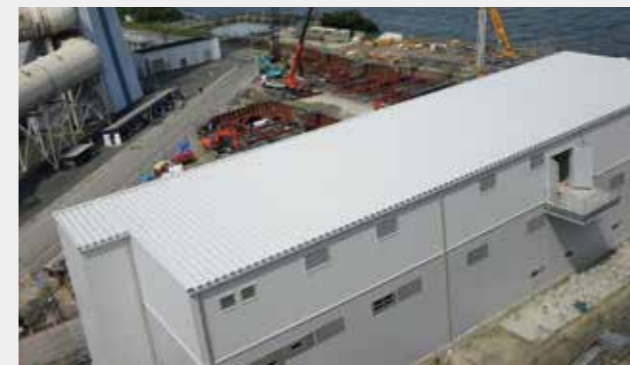
火力発電所 / 千葉県
