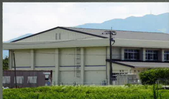
福田小学校体育館 / 福岡県
