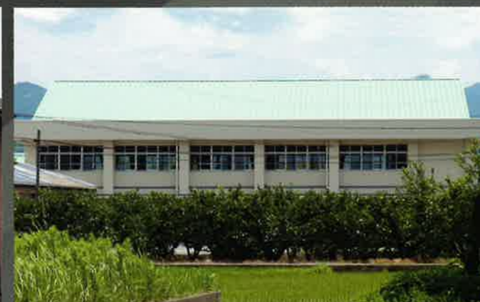
久喜宮小学校屋内運動場 / 福岡県
